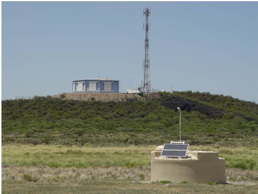
En primer plano, uno de los 1600 detectores de superficie que compondrán el Observatorio Pierre Auger. Al fondo, el edificio de Los Leones, albergando 6 telescopios de fluorescencia, y la antena de comunicaciones.
